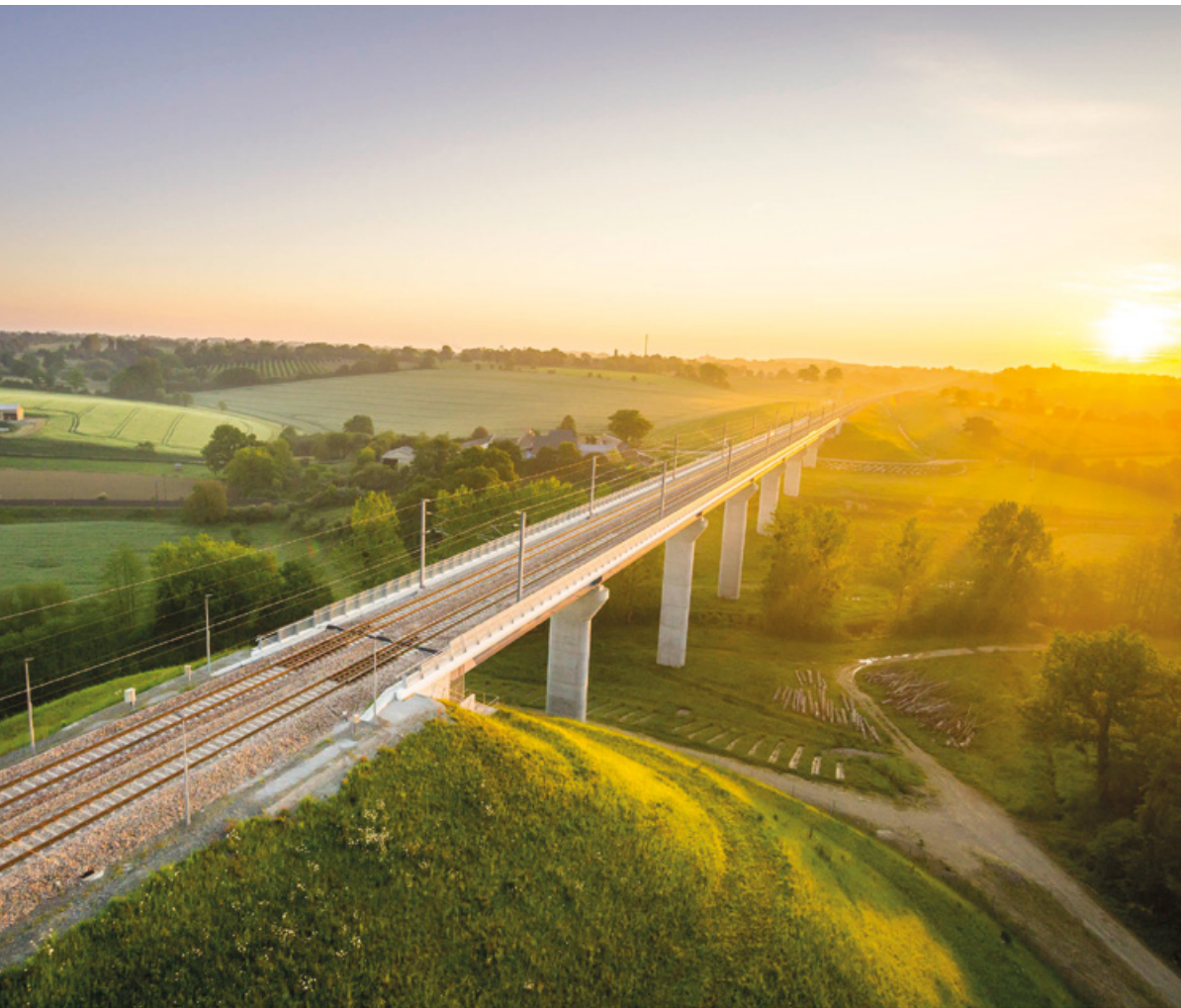
Viaduc du Vicoin à Saint-Berthevin sur la ligne à grande vitesse Bretagne - Pays de la Loire exploitée jusqu'en 2036 par Eiffage.
